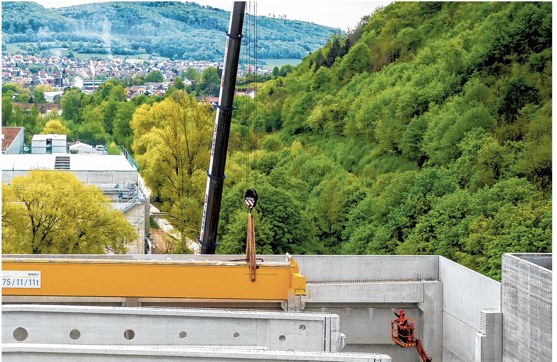
Mitte März installierte das Team von Gloning in der neuen Palm-Papiermaschinenhalle die Kranbahn, die sich insgesamt über einen halben Kilometer Länge erstreckt. In Stöttlen erhielten derweil die Kastenträger ihre Lackierung. Anschließend wurde die komplette Anlage inklusive des Hubwerks aufgebaut und auf alle Funktionen getestet, dann wieder für den Transport demon- tiert.
